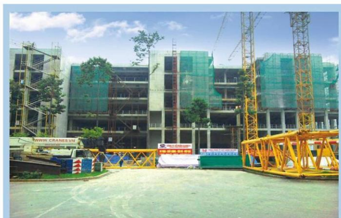
Lắp hệ thống điện Nhà Quốc Hội Installation of power system for National Assembly House
