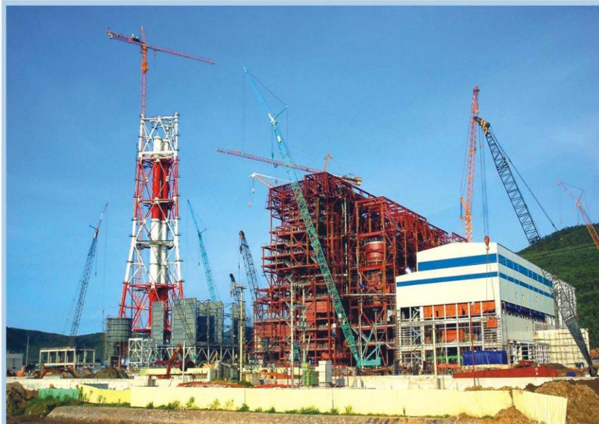
Nhà máy Nhiệt điện Nghi Sơn 1 Nghi Son 1 thermal power plant
