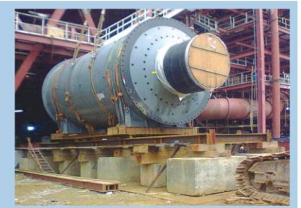
Lắp đặt hệ thống nghiền than Nhà máy Nhiệt điện Vũng Áng 1 Installation of coal mill for Vung Ang thermal Power Plant
