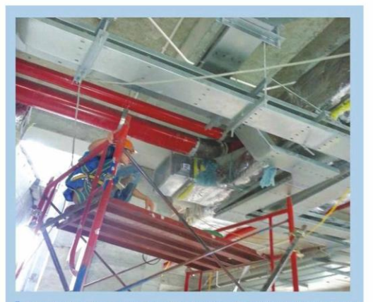
Lắp hệ thống thang máng cáp, ống điều hòa, ống cứu hỏa Nhà Quốc hội Installation of cable ladder/tray, air-conditioning pipeline, fire extinguisher pipeline for National Assembly House
