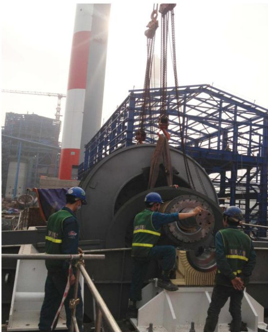
Lắp hệ thống lọc bụi tĩnh điện Nhà máy Nhiệt điện Mông Dương 1 Installation of electrostatic dust filter system for Mong Duong 1 thermal Power plant
