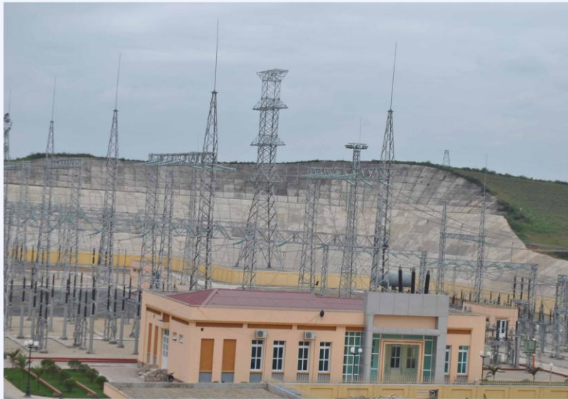
Nhà điều khiển trung tâm trạm 220kV Bim Sơn
